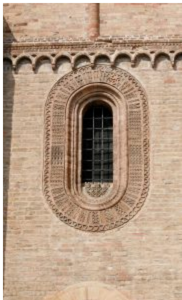
Particolare del campanile
